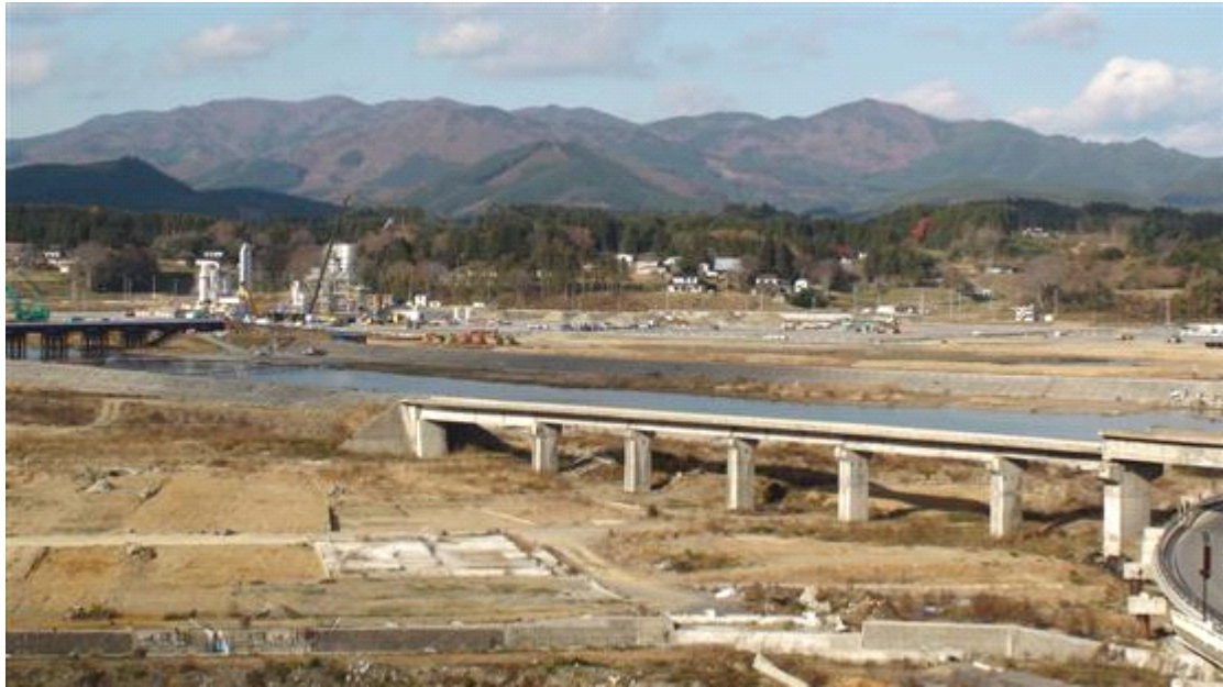
小泉中学校北側。津谷川の向こう側にがれき処理場ができつつある。手前の橋梁は気仙沼線。右下は国道 45 号線（2012 年 10 月 24 日撮影）
