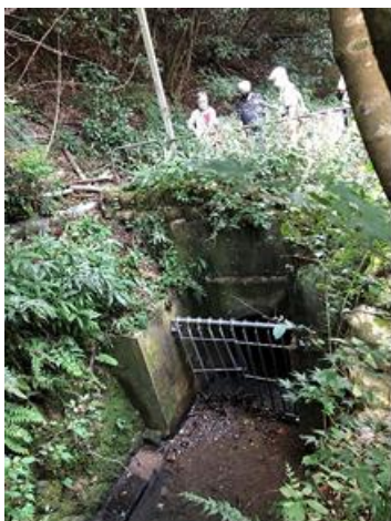
山内町の川と下水管の間の柵
